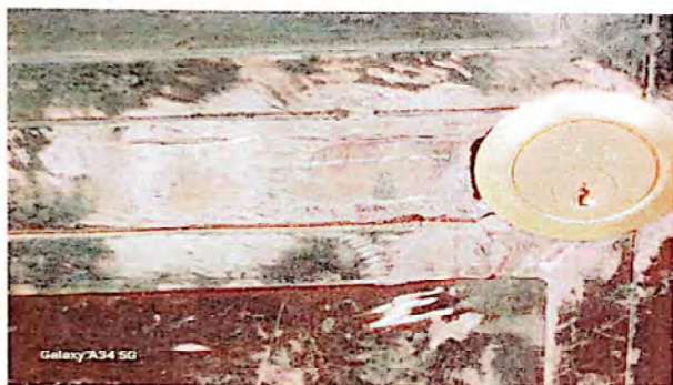
FOTO3: SUSTITUCIÓN DE CHAPA
