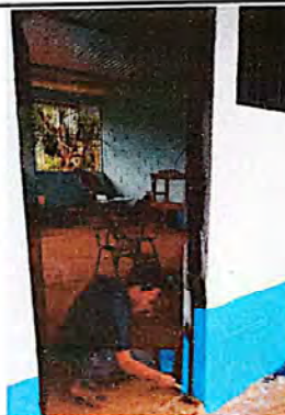
FOTO4: SUSTITUCIÓN DE PUERTA
