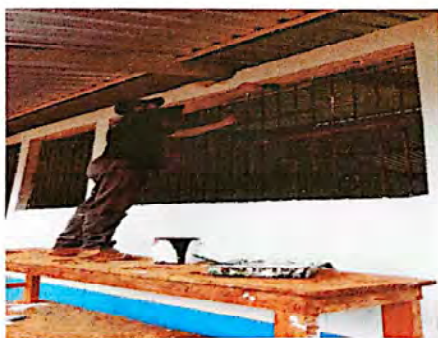
FOTO5: MANTENIMIENTO DE ESTRUCTURA DE METAL DE VENTANA
