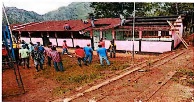
FOTO1: SUSTITUCIÓN DE LÁMINAS, POR LÁMINAS TROQUELADAS CALIBRE 26
