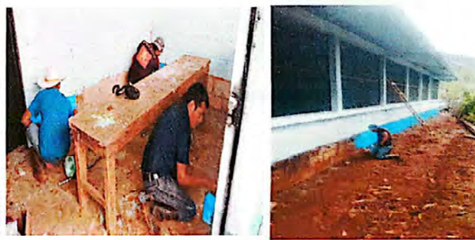
FOTO6: PINTURA EN MURO DE INTERIOR Y EXTERIOR
